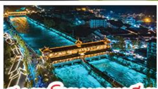
สะพานโบราณหนานเหลียว
